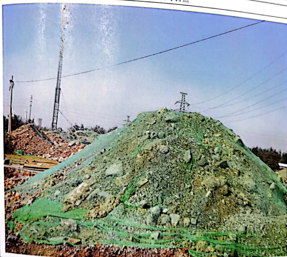
基础开挖临时堆土苫盖
