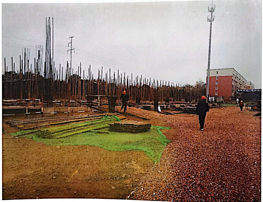
场内施工道路随时压盖
