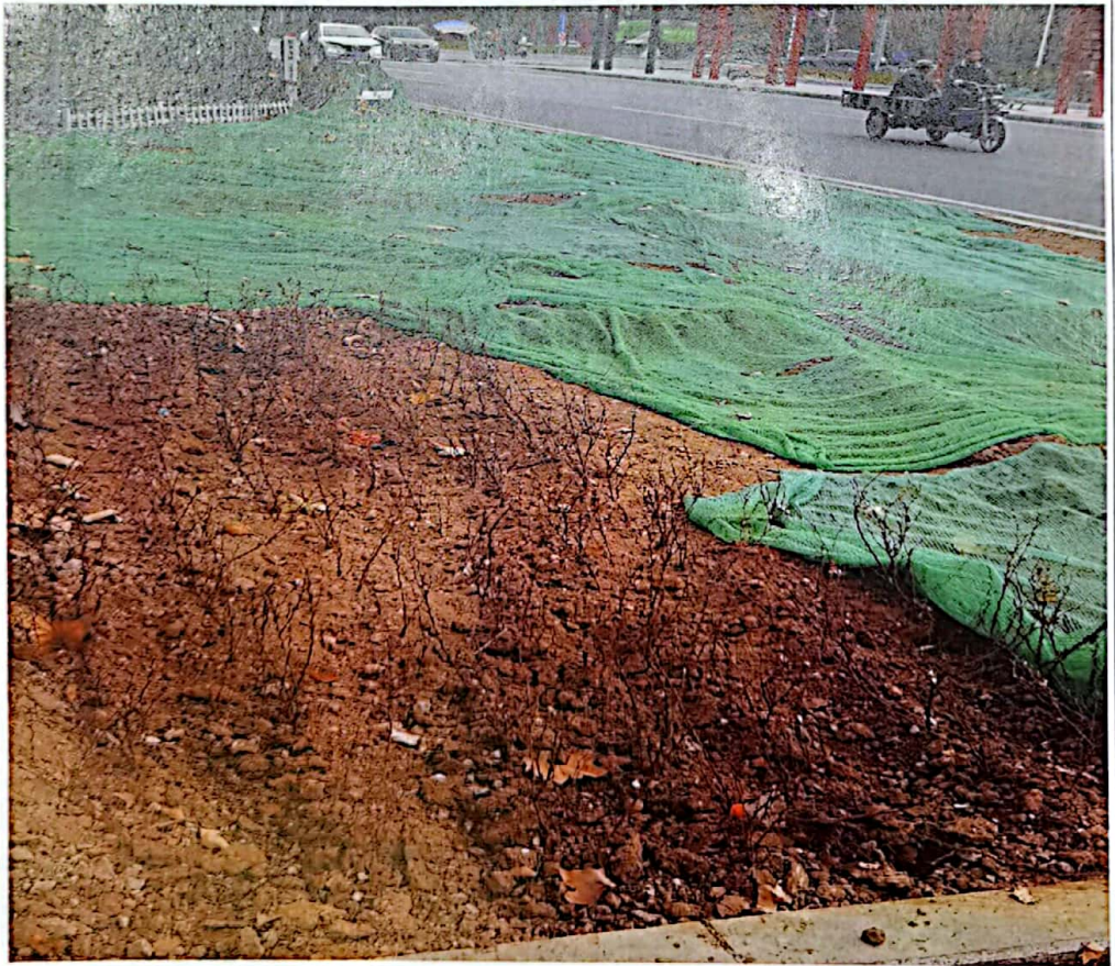
人民路绿化及施工区临时苫盖
