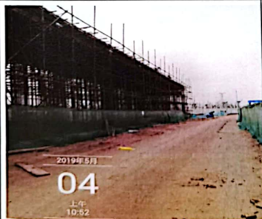
施工分区临时分割拦挡
