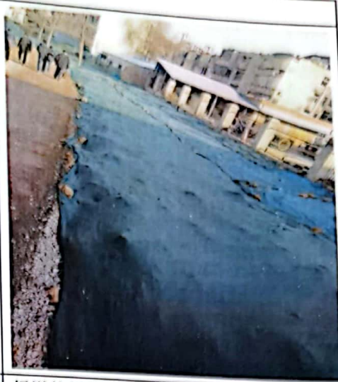
绿道待绿化区土工布苫盖
