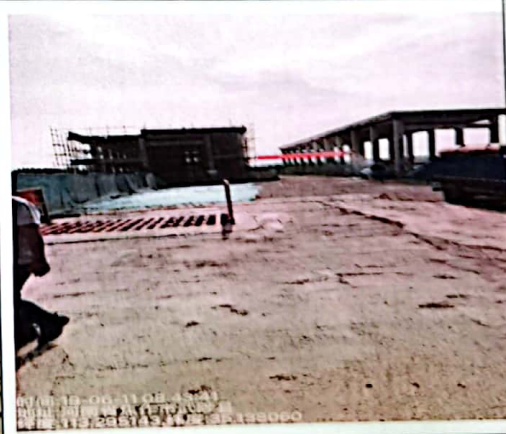
施工裸露区硬化及防尘网苫盖
