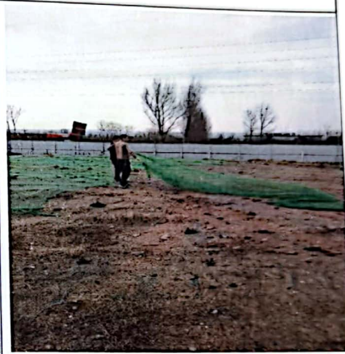
防尘网二次苫盖
