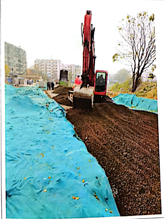
施工裸露区土工布苫盖
