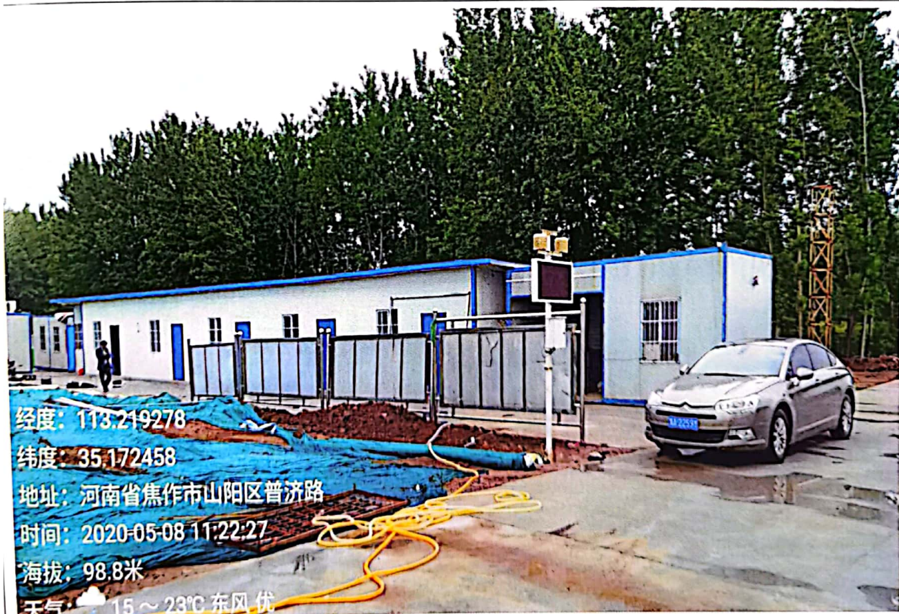
大北张停保场裸露地表土工布苫盖
