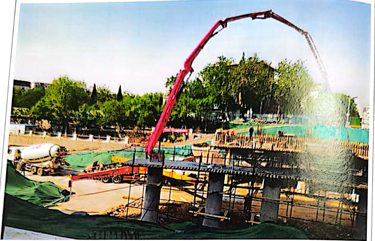
桥梁施工临时堆土堆料土工布苫盖
