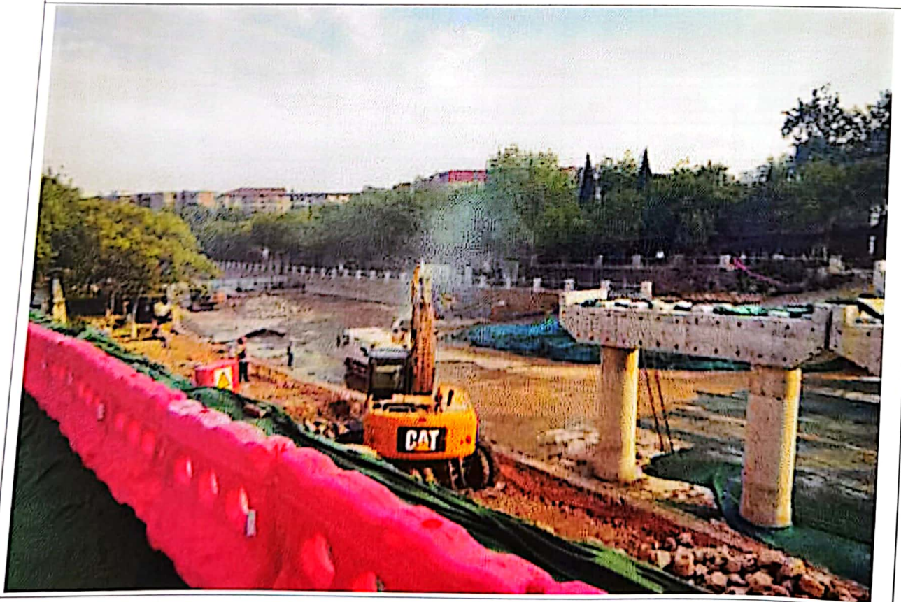
桥梁施工区洒水降尘及苫盖
